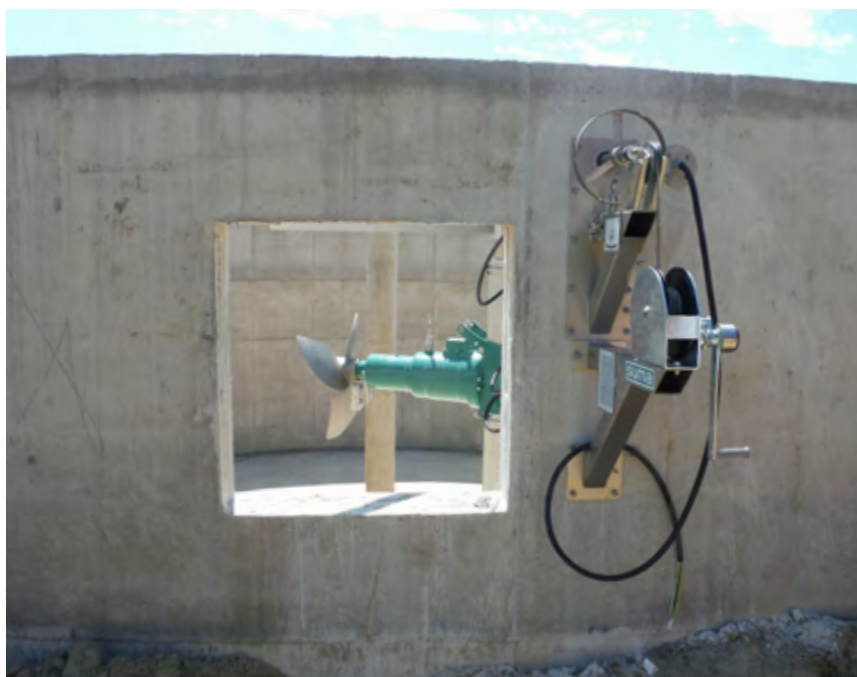
MGD – zbiornik betonowy z 2G
