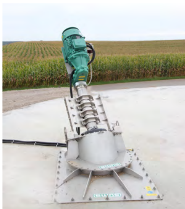
Montaż dachowy AMX – zbiornik zamknięty
