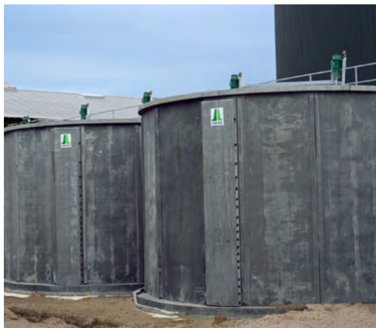
BG2 na stropie zbiornika – zbiornik betonowy
