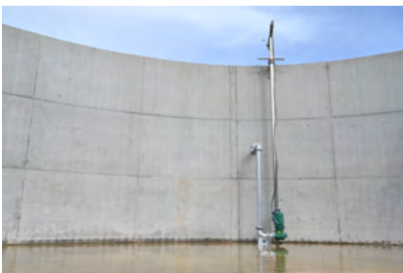
PRESSURA TP - zbiornik betonowy
