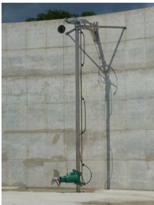
MGD – zbiornik betonowy z 2G
