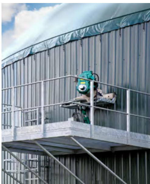
FT HY z siłownikiem hydraulicznym - zbiornik betonowy
