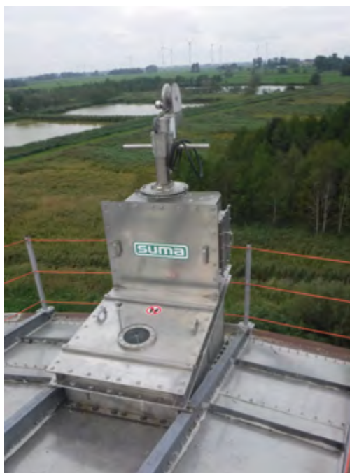
GDD – zbiornik stalowy
