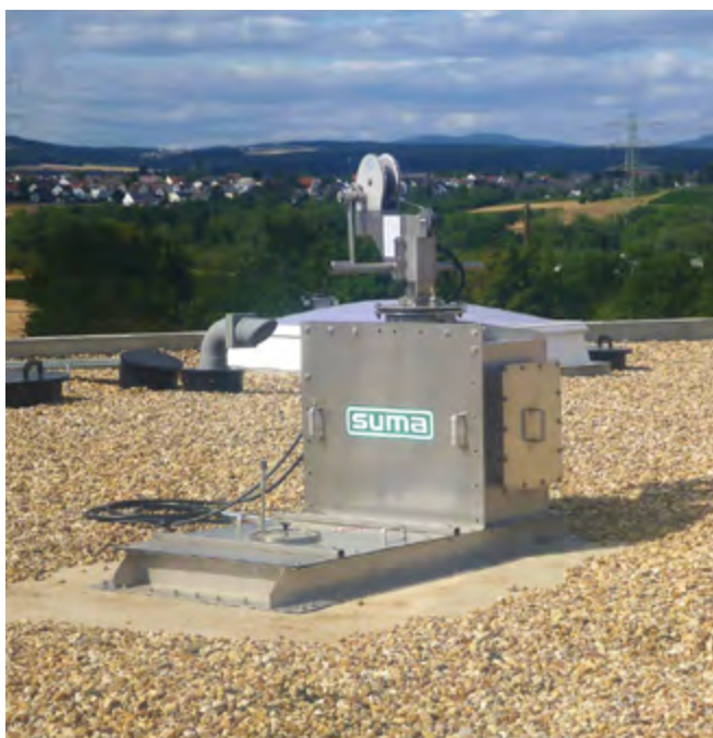
GDD – zbiornik betonowy
