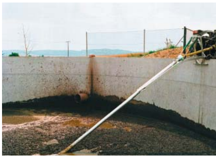
Rührgigant Z4 an einer offenen Grube
