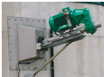
Rührgigant FR mit 30° Dichtplatte
